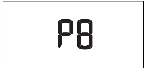
Fig. 13 P8 - Control de luminosidad
